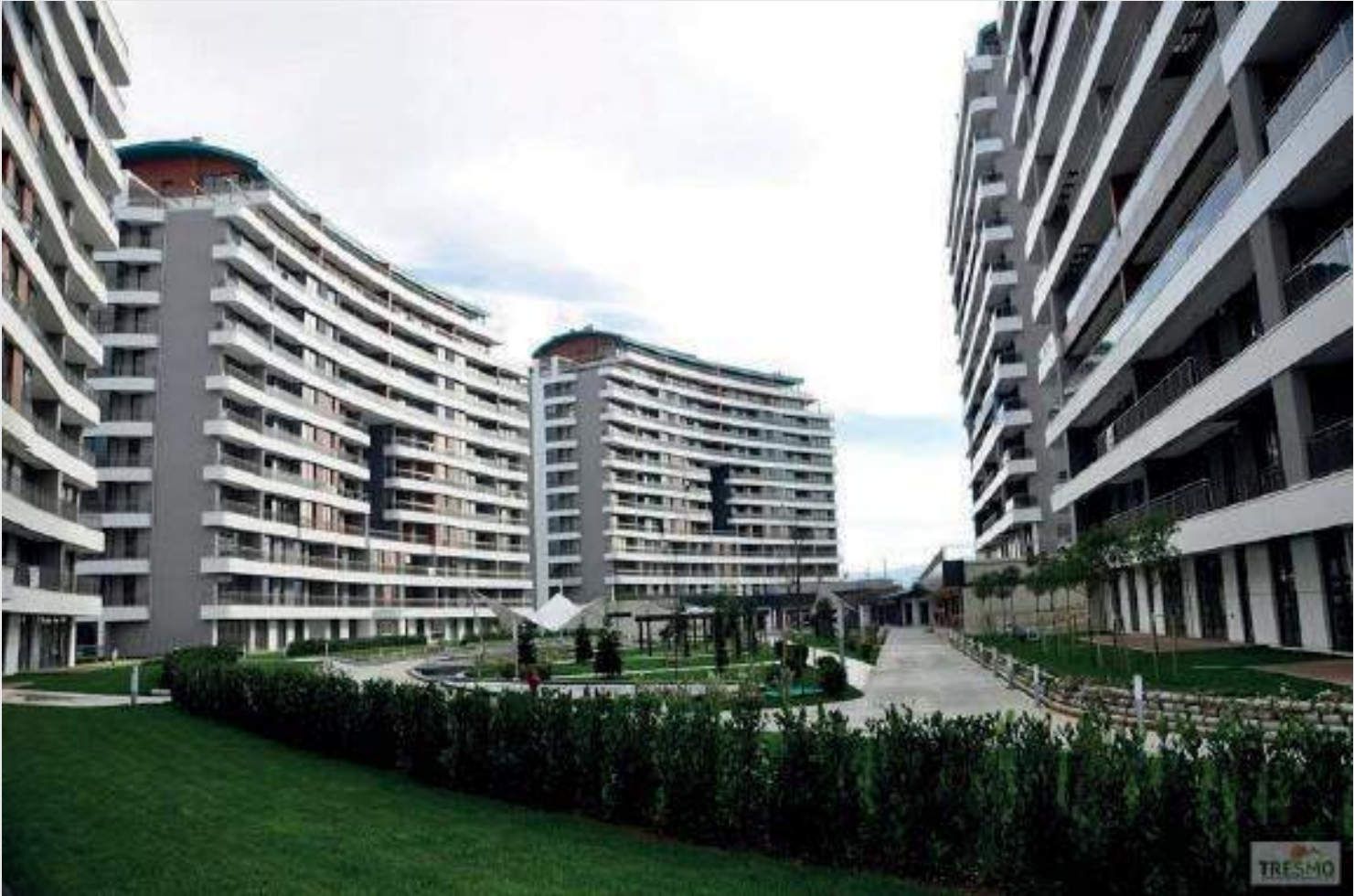
SAYKAR İNŞAAT / Tuana Evleri - KOCAELİ
